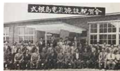
電気送電 65 周年
